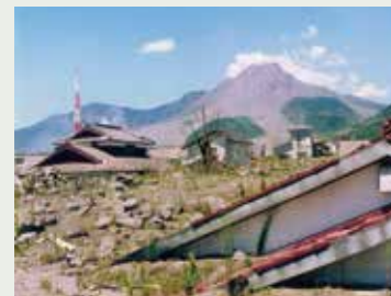
土石流被災家屋
