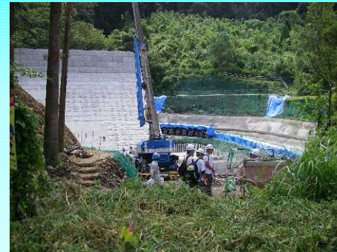
講義:砂防工事現場体験
